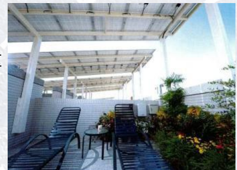
住宅樓頂案例(10坪) 4.4瓩
