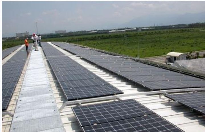
屏東縣 120kWp (多晶矽)
