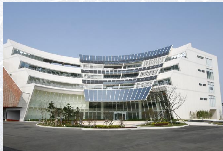
桃園縣 19.8kWp (多晶矽) (建築物設計階段即納入太陽光電)
