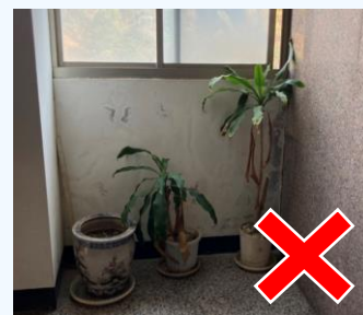
▲ 共同走廊堆置雜物
