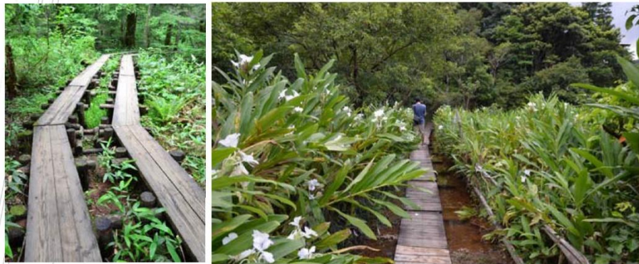
泥灘地步道以簡易、耐水淹(架高型棧道或固化土)之原則規
