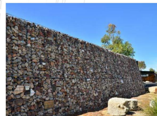
石籠護岸、石籠擋土牆設置，穩固潮溝、潮池及竹船停泊點之高程落差
